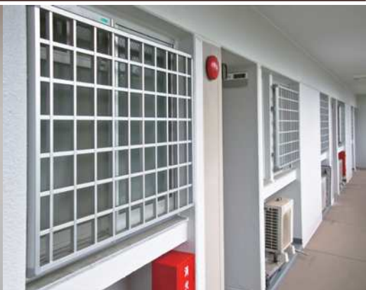
【組子格子タイプ（入隅納まり）】 集合住宅共用廊下側に取付。
